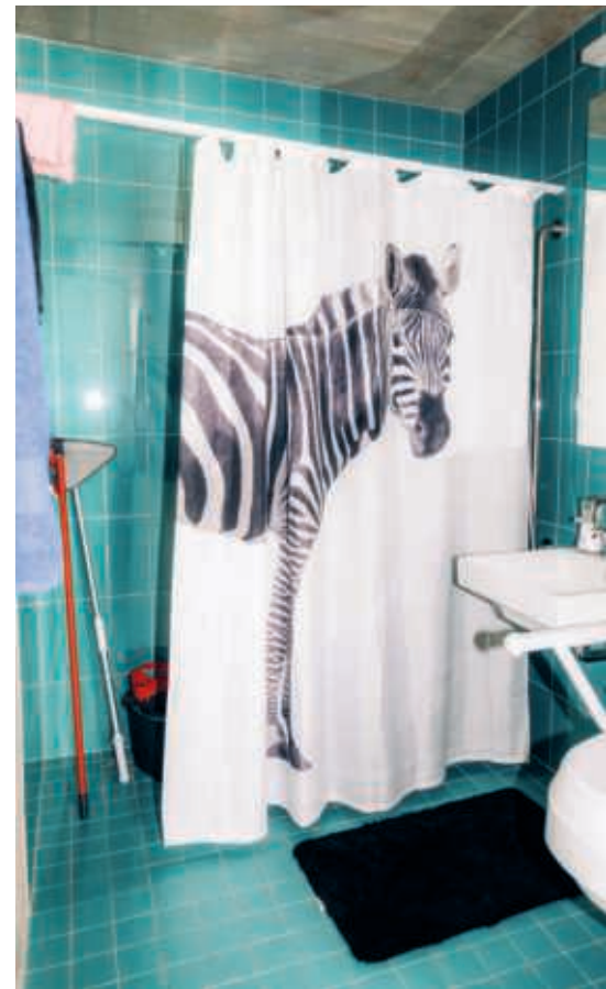
Keine Schwellen, dafür Haltegriffe und genug Raum, dass auch das Zebra sich umdrehen könnte: das barrierefreie Badezimmer.
