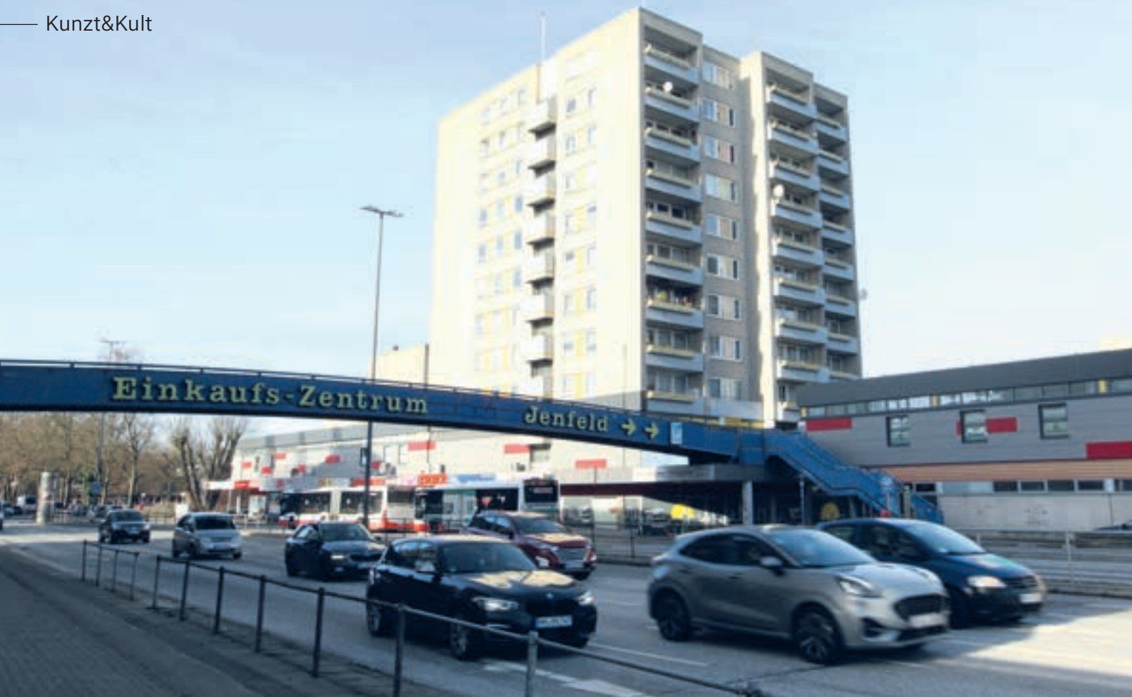
Die „Blaue Brücke“ über der Rodigallee: markantes Bauwerk im Herzen des Hamburger Stadtteils Jenfeld
